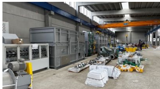
Plant di Oggiono - Installazione del nuovo impianto di tempratura
